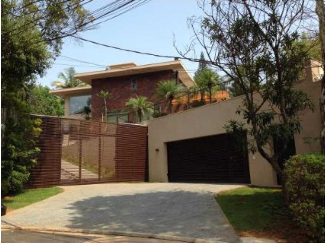
Figura 11: Fachada da edificação após a conclusão das obras.
