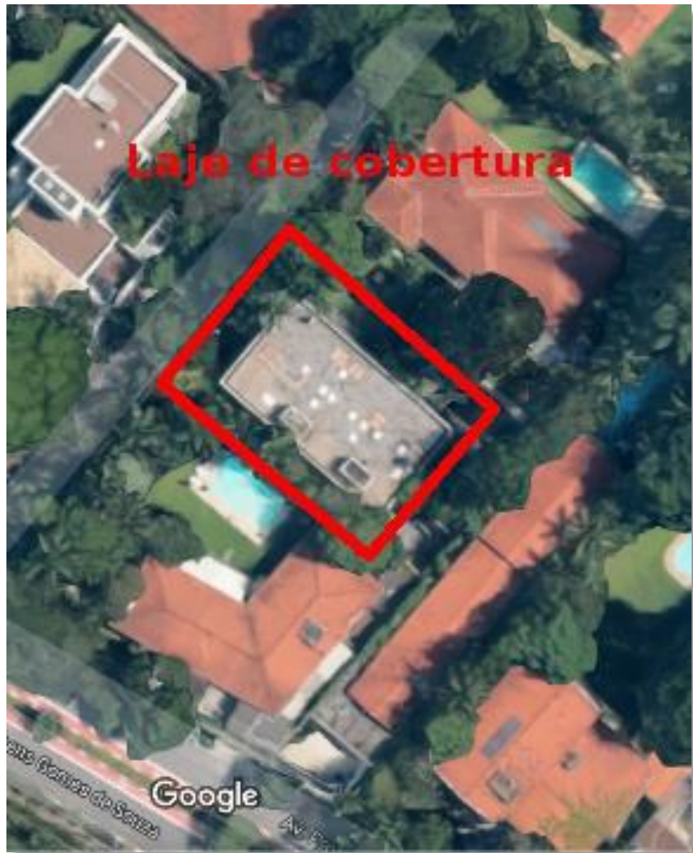
Figura 20: Laje de cobertura da edificação anterior a reforma sem a instalação do SAS.
