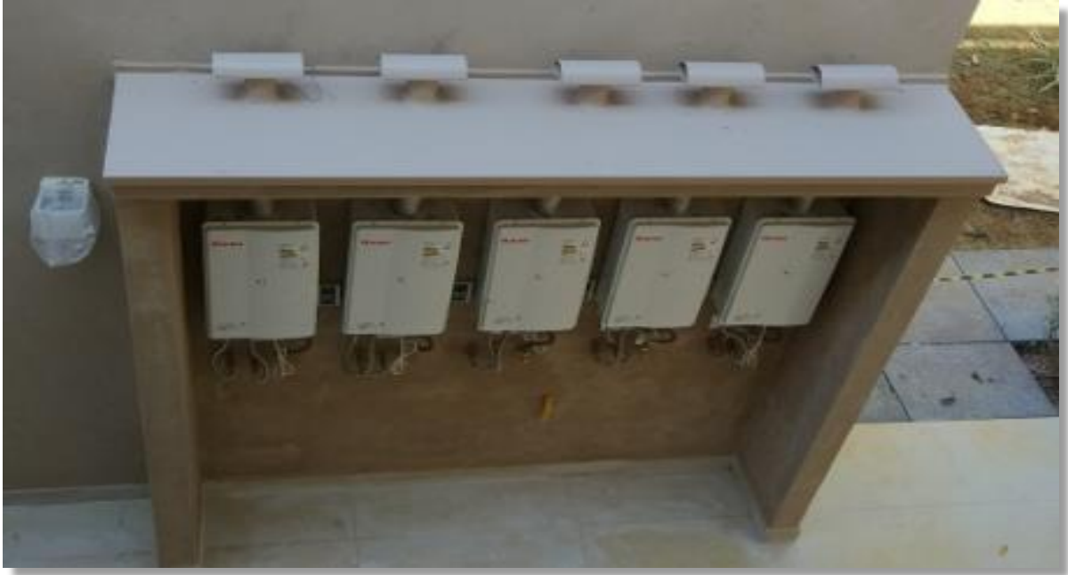
Figura 14: Abrigo de aquecedores. Sistema de apoio de aquecimento para banhos e SPA. Fonte: Acervo próprio
