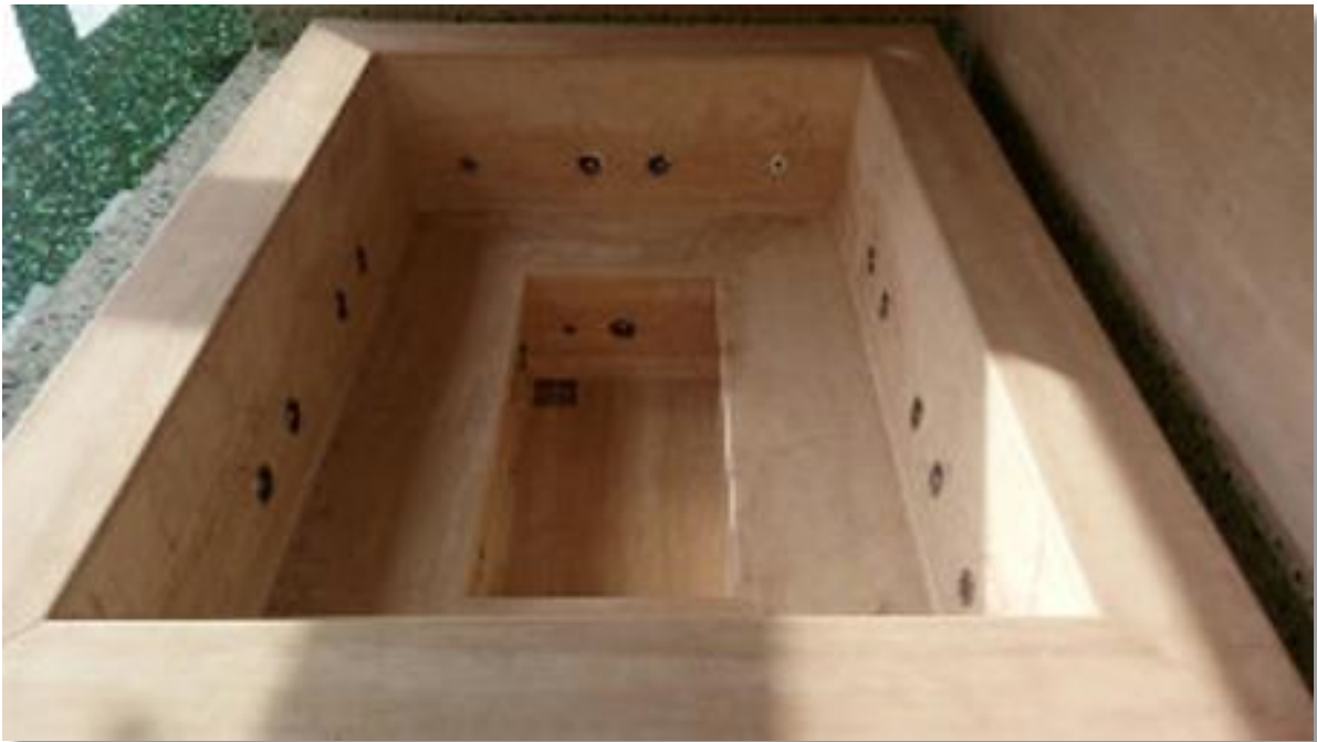
Figura 13: Detalhe banheira recreativa SPA. Nota-se que o volume de água do SPA não se comunica com a água da piscina, portanto não há troca térmica entre os dois volumes. Fonte: Acervo próprio
